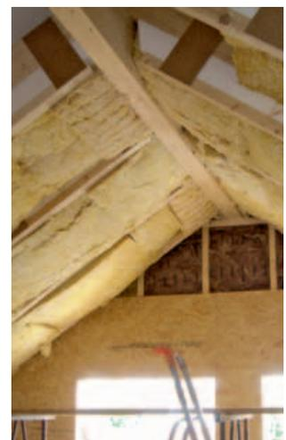
Zwischensparrendämmung des Schrägdachs
