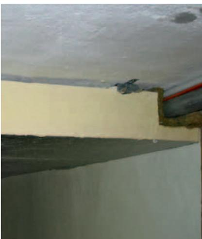
Kellerdeckendämmung mit Einbeziehung von Rohrleitungen
