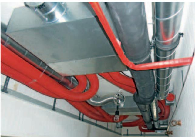
Lüftungsanlage in der abgehängten Decke (vor Verkleidung)
