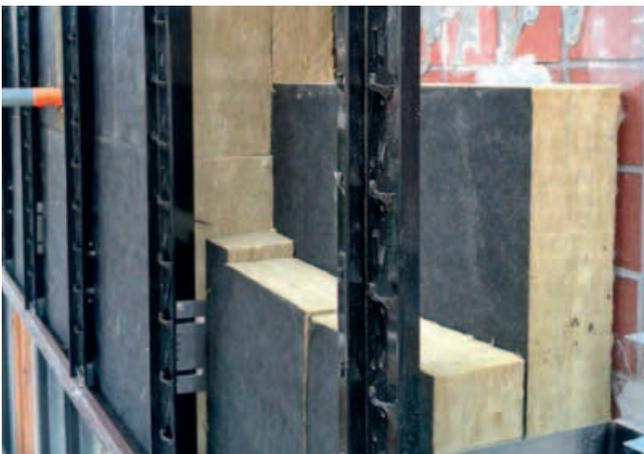
Unterkonstruktion der Vorhangfassade mit Wärmedämmung
