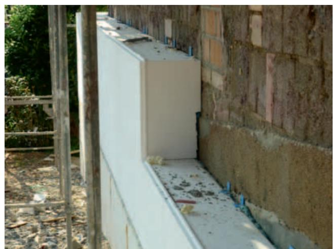
Außenwanddämmung mit einem WDVS
