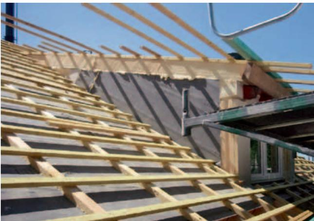
Dämmung der Dachgaube
