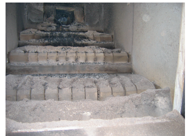
Kesselbrennraum (Treppenrostfeuerung)
