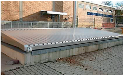
HHS-Brennstofflager (Tiefsilo) einer Schule
