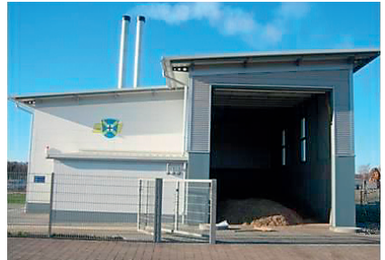
Verschiedene ebenerdiges Heizhäuser mit überdachtem HHS-Silo
