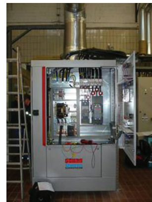
Blockheizkraftwerk in der JVA Darmstadt © HBM
