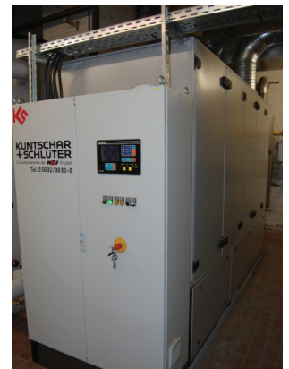
Das BHKW in der Kooperativen Gesamtschule Sehnde erzeugt gleichzeitig und hocheffizient Wärme und Strom © WISAG
