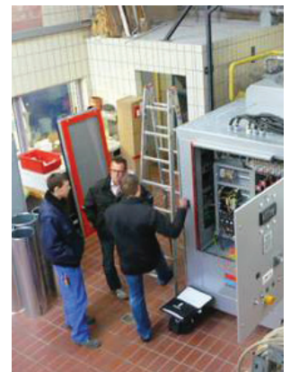
Besprechung bei der Montage des Blockheizkraftwerks im Heizungsraum © HBM
