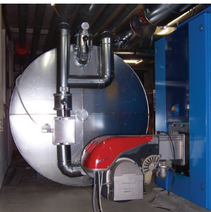
Blockheizkraftwerk im Heizungskeller des Gemeinderathauses © Siemens AG
