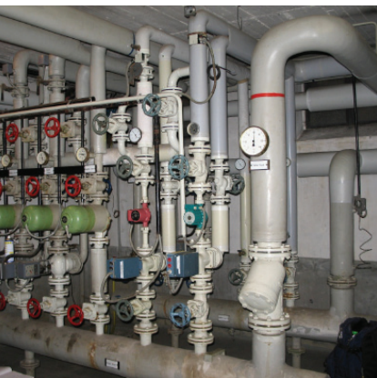
Heizkreisverteiler der Heizzentrale in der Schule der Gemeinde Hude © JCI
