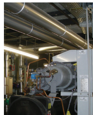
Heizungskeller der Universität Kassel - hier steht das BHKW. © HBM
