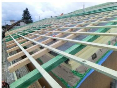
Aufsparrendämmung mit aufgesetzter Dachlattung
