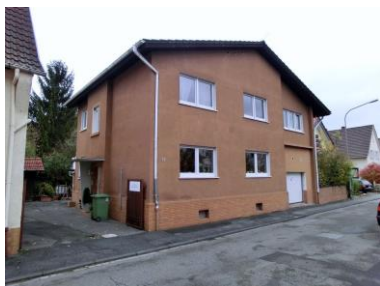
Gebäude vor der Modernisierung
