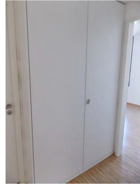
Technikschrank je Wohnung
