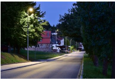
Beleuchtungssituation in der Haddamshäuser Straße nach der Modernisierung
