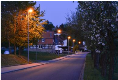
Beleuchtungssituation in der Haddamshäuser Straße vor der Modernisierung
