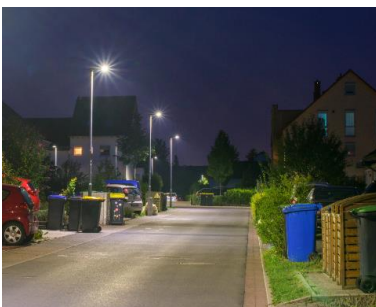
Beleuchtungssituation im Achstatttring nach der Modernisierung
